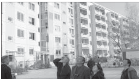
Modernisierte „Platte“ in Gera/Thüringen
